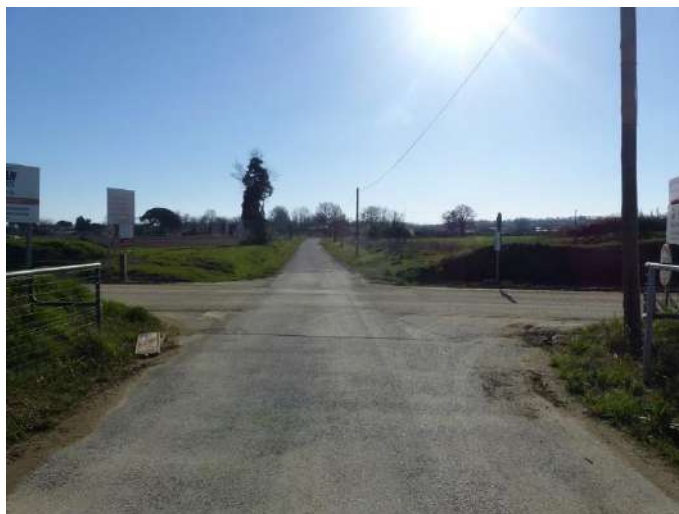
La RD 10c au droit de la traversée de la piste privée
