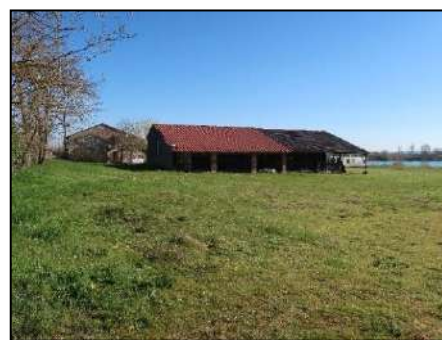
Habitation au lieu-dit « Pichet » Source : Artifex 2019
