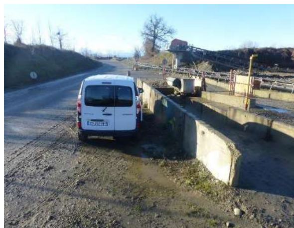
L'accès à la carrière en exploitation sur la piste privée et la bande transporteuse
