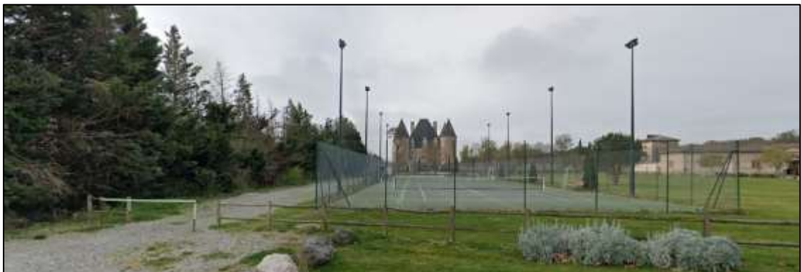
Fig. 4. Vue sur le château depuis le Nord, avec limite végétale (haie de conifères) en bordure du secteur à urbaniser
